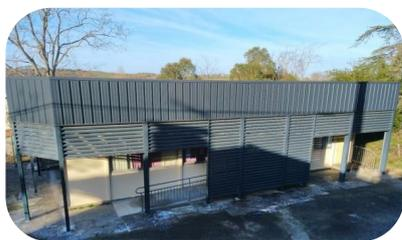
Pour mémoire, ces travaux avaient pour but essentiel « d'envelopper » le préfabriqué existant d'une structure métallique afin d'isoler le toit et d'amener de l'ombre sur les côtés par des brise-soleil pour améliorer l'isolation thermique du bâtiment.
